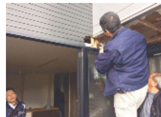
ベランダと外壁の取り合い解体
