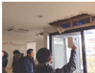
室内側から壁内の状況確認
