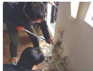
壁内の結露状況を確認
