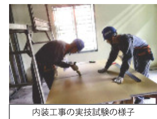
内装工事の実技試験の様子
