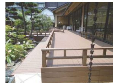
完成したデッキ部分、フクビ化学の再生木材 プラスッドを使い、キレイな仕上がりです。
